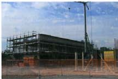
I lavori in corso all'ex Macello
